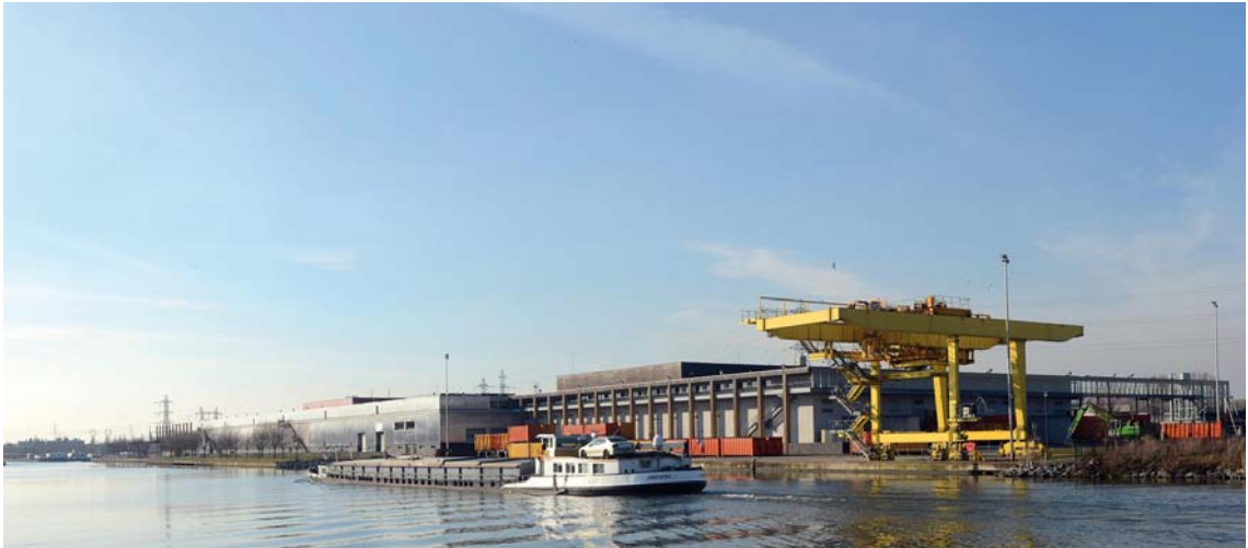
Le Centre de valorisation organique (CVO) traite aujourd'hui plus de 70 000 tonnes de déchets par an et évite ainsi leur incinération ou leur mise en décharge
