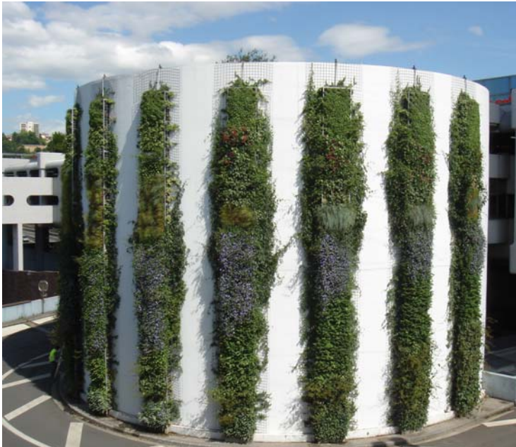
Murs végétalisés réalisés par Canevaflor à Lyon
